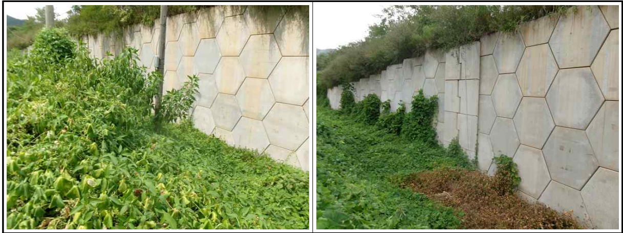
【사진 11.3.1】 지반, 기초부 전경
