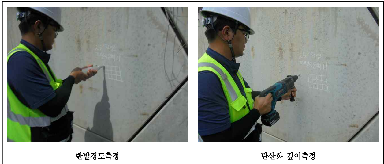
【사진 11.4.1】 재료시험 조사 전경
