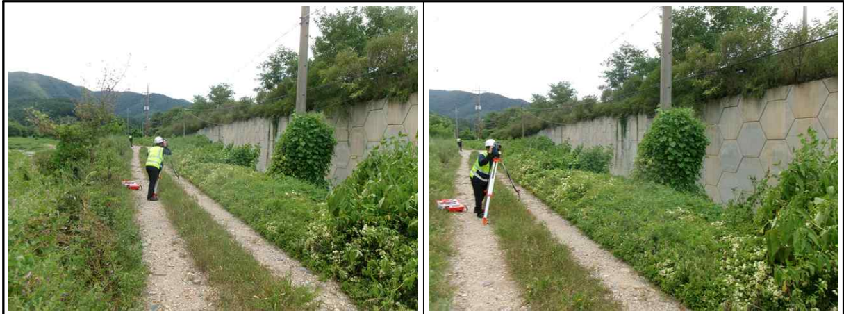
【사진 11.4.2】 측량작업 전경
